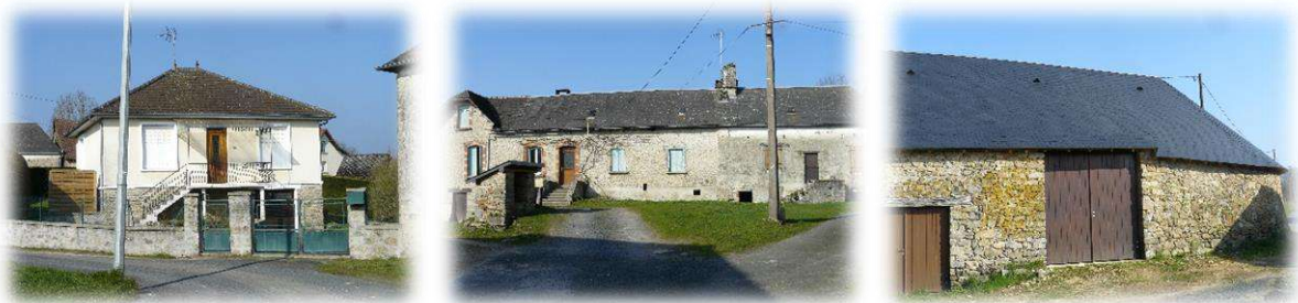
Photographie 16: Bâti présent sur le secteur de Chatras
