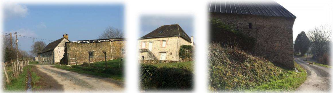
Photographie 24: Bâti présent sur le secteur du Mons
