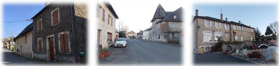
Photographie 14 : Bâti présent sur le secteur du Bourg
