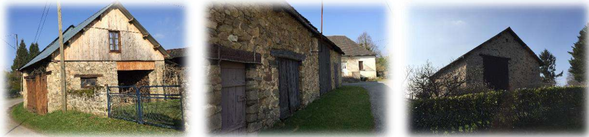
Photographie 18: Bâti présent sur le secteur de Freyssinet
