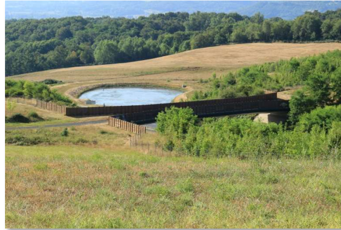
Passage à faune sur la route entre la route Les Marnas et la Route de la Bombetterie
