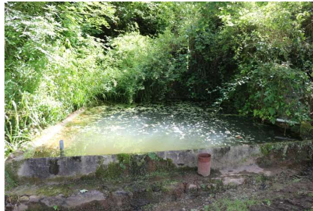
Mare artificielle à renforts bétonnés mais accolée à une zone de boisements sur la commune d'Ayen
