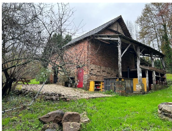
Vue sur le bâtiment technique (stockage et sanitaire)
