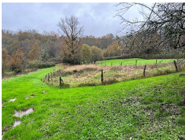
Vue sur le dispositif d'assainissement autonome de la propriété
