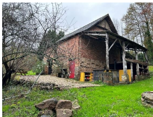
Vue sur le bâtiment technique (stockage et sanitaire)
